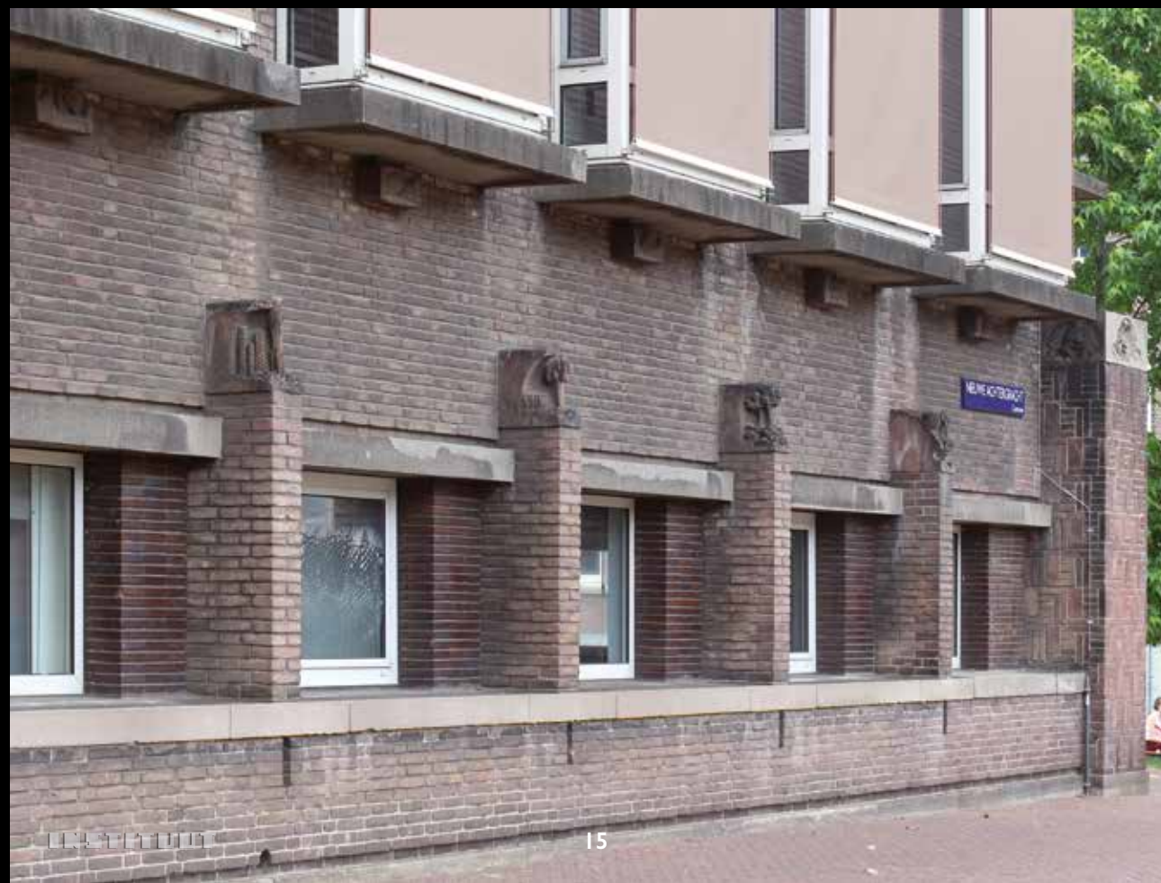
Gevelwand van het souterrain van het Geologisch Instituut aan de Nieuwe Achtergracht.
