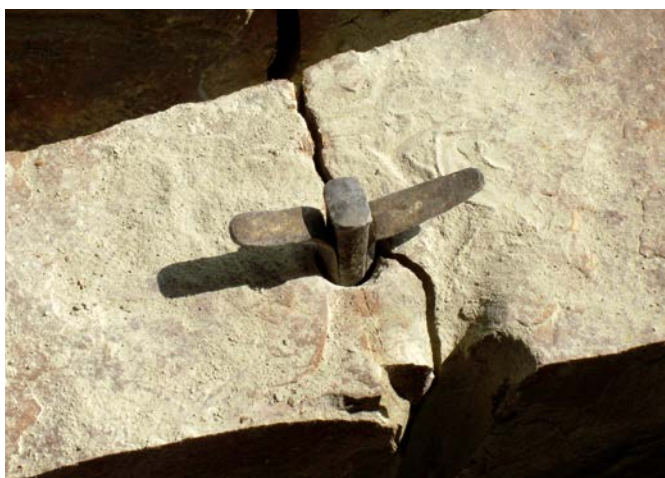
AFB. 12 | HET KLOVEN VAN DE ZANDSTEEN MET STALEN WIG EN BEITEL.
